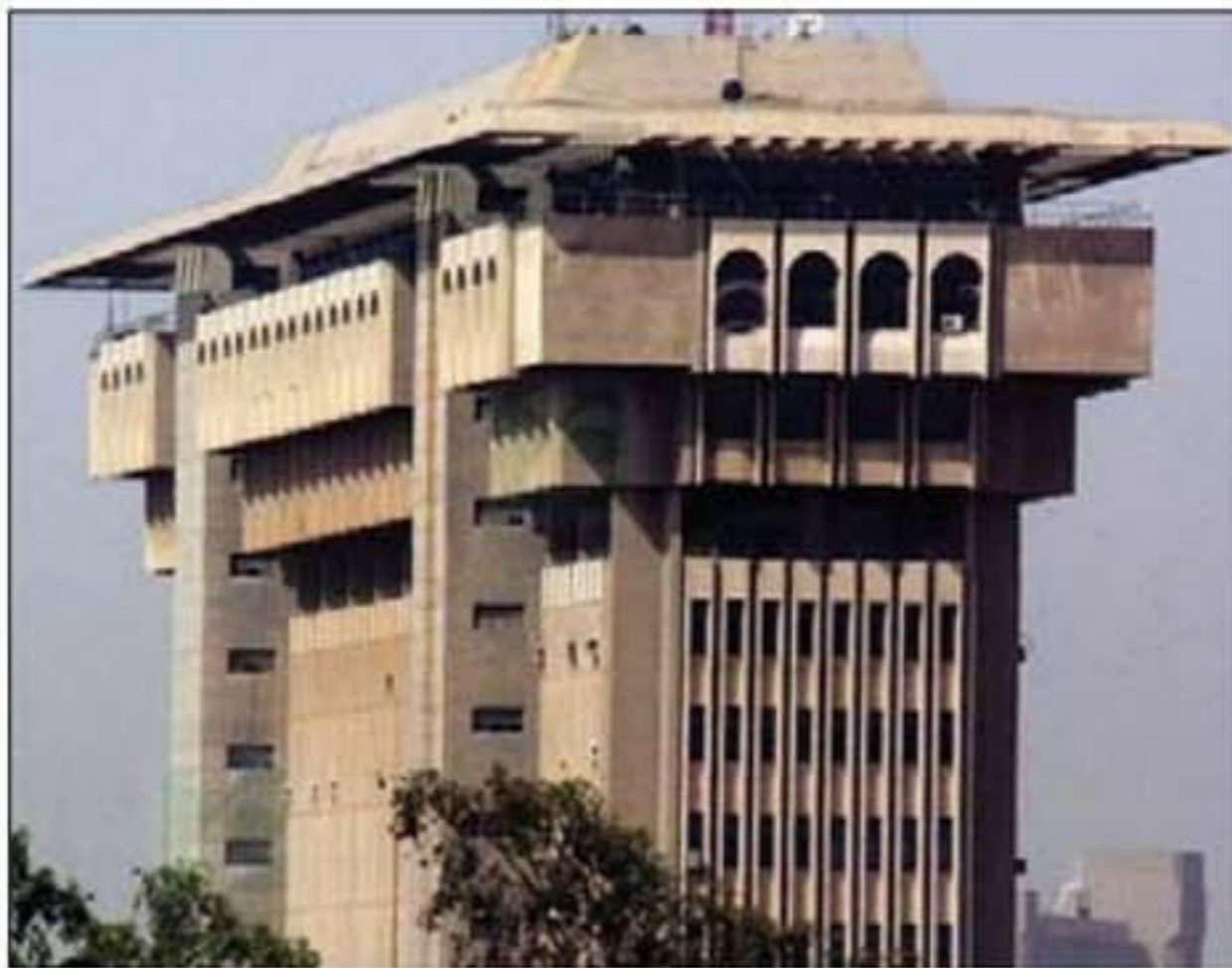
مبنى وزارة الداخلية
