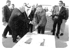
إعطاء إشارة حفر في مشروع محطة حاويات الشركة الدولية بميناء ديمياط
