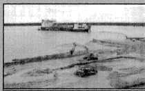
شكل (5) إنشاء/تكوين مناطق الرفع خلف الأرضفة من نواتج التكريب باستخدام المعدات الأرضفة
