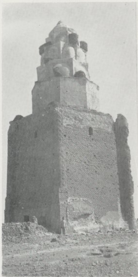
الشكل (٢٤) : مشهد امام الدور قبل أعمال الترميم
