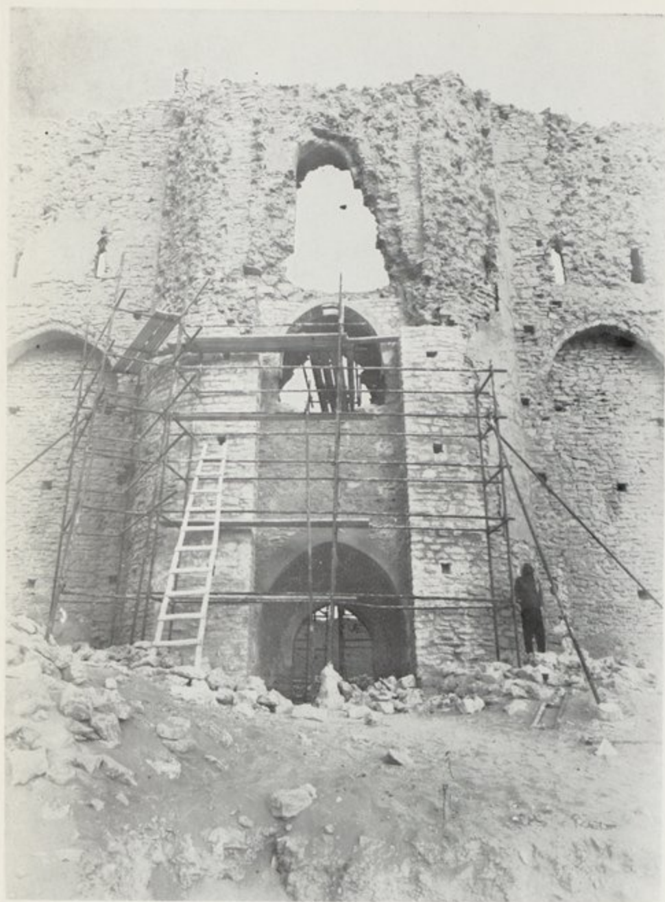
أشمل (٤٣) الاخضر : واجهة المدخل الشرقي أثناء الصيانة الأثرية
