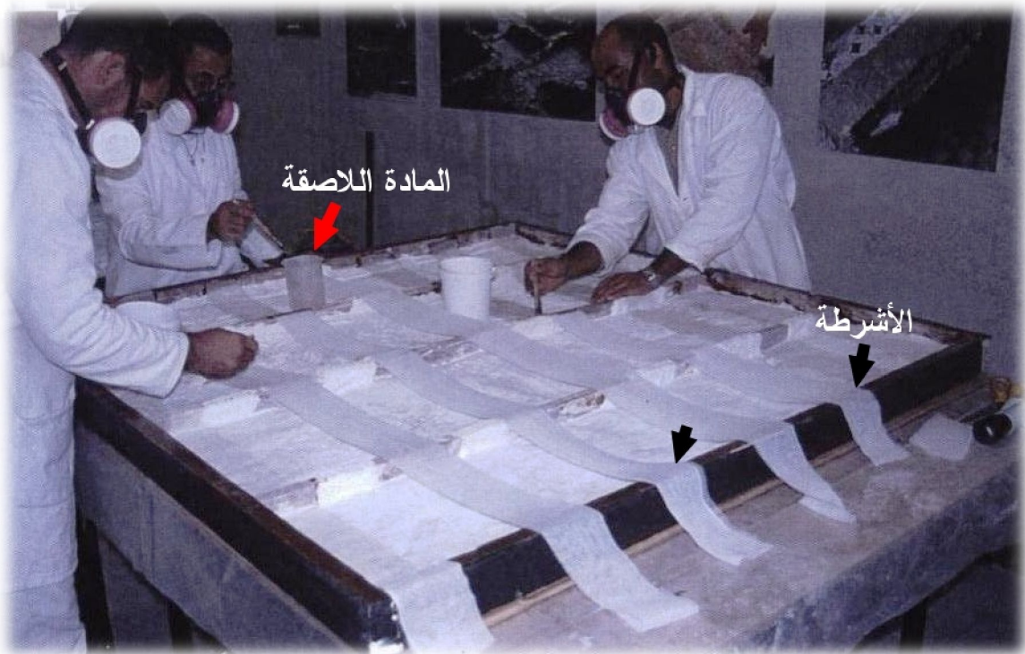
الصورة 63 قفا التبليط قبل الصيانة (سند جيسي)
