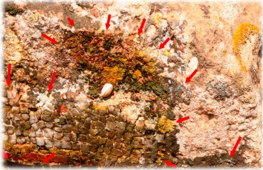
الصورة 59 تلف البيولوجي (إنتشار الأشنات و الطحالب) . التبليط رقم 23
