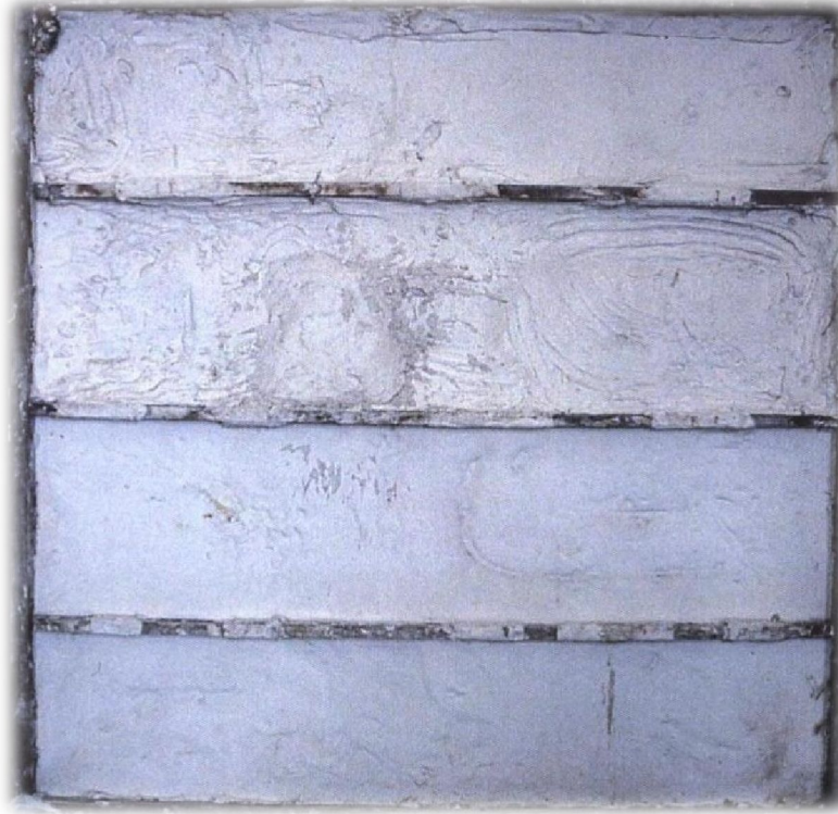
الصورة 63 قفا التبليط قبل الصيانة (سند جيسي)
