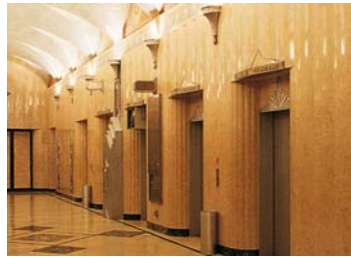
مصعد misAad | elevator
