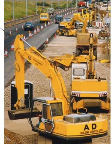
إعادة رصف iAaadat rasf resurfacing
