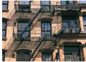
مهرب حريق mahrab Hareeq fire escape
