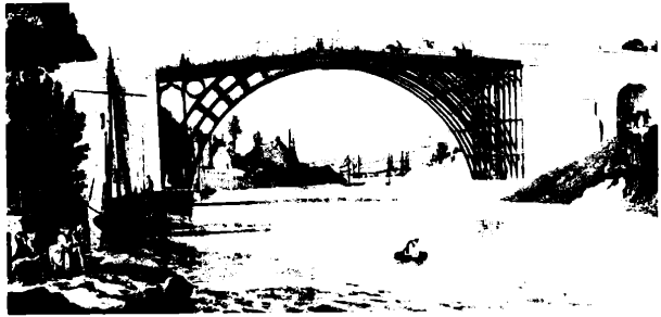
٢٦٢ جسر كولبروكديل في شروبشر. ١٧٧٧ - ١٧٨١. تصميم برنجانارد. يعتبر أول جسر انشأ من مادة الحديد الصلب.
